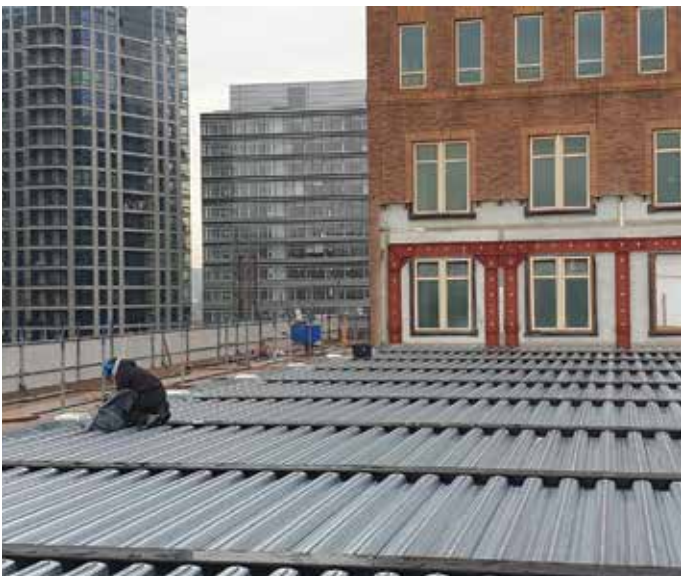
4. Leggen geïntegreerde staalplaten verdiepingvloer. Op de achtergrond is de ingreep op de bestaande gevel zichtbaar.
