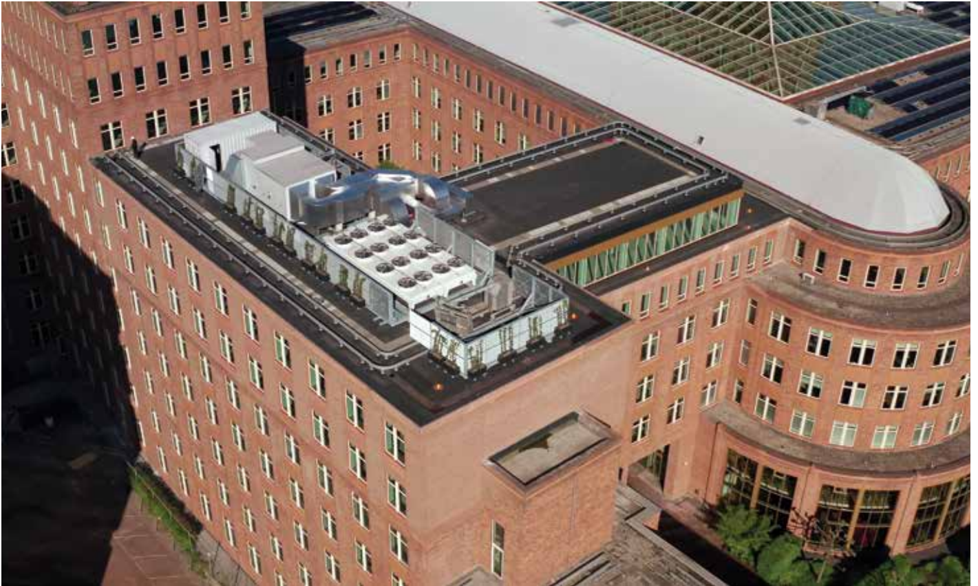
1. Gerealiseerde optop met op de voorgrond bouwdeel C2 (met installaties op het dak) en loodrecht hierop, met terugliggende glazen gevel, bouwdeel B2.
