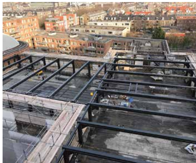
8. Staalconstructie nieuwe verdiepingvloer in opbouw.
