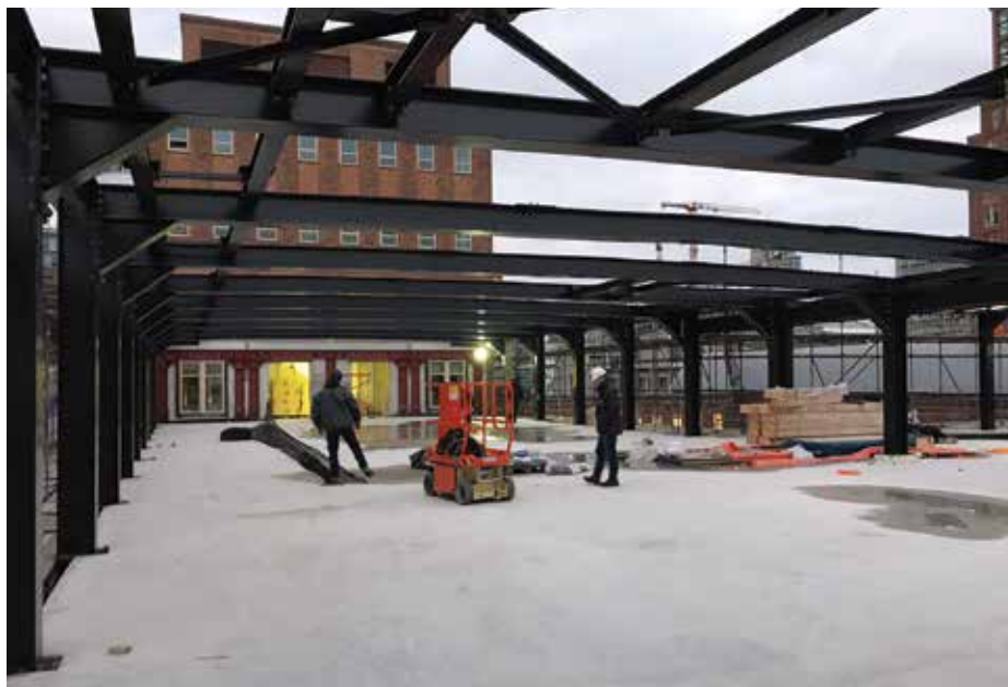
9. Dakconstructie in opbouw.
